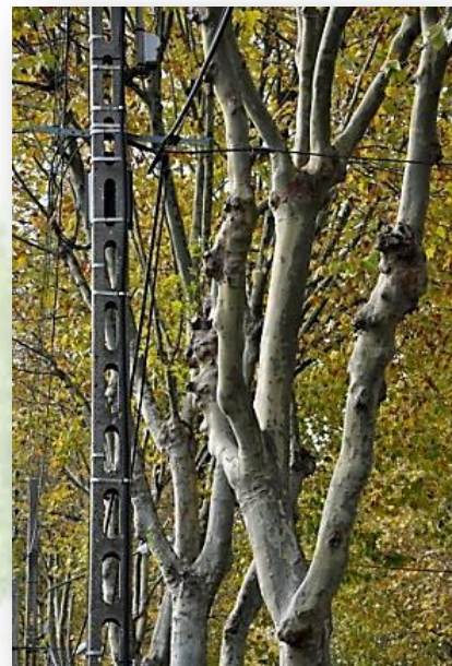
Cohabitation avec le réseau aérien
